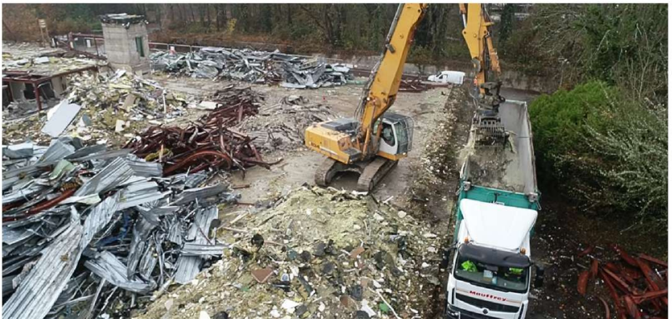
Travaux de déconstruction sur l'ancien site IBM, Combleux (45)
