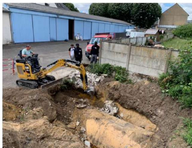
Extraction de cuve à fioul - Châteaudun (28)
