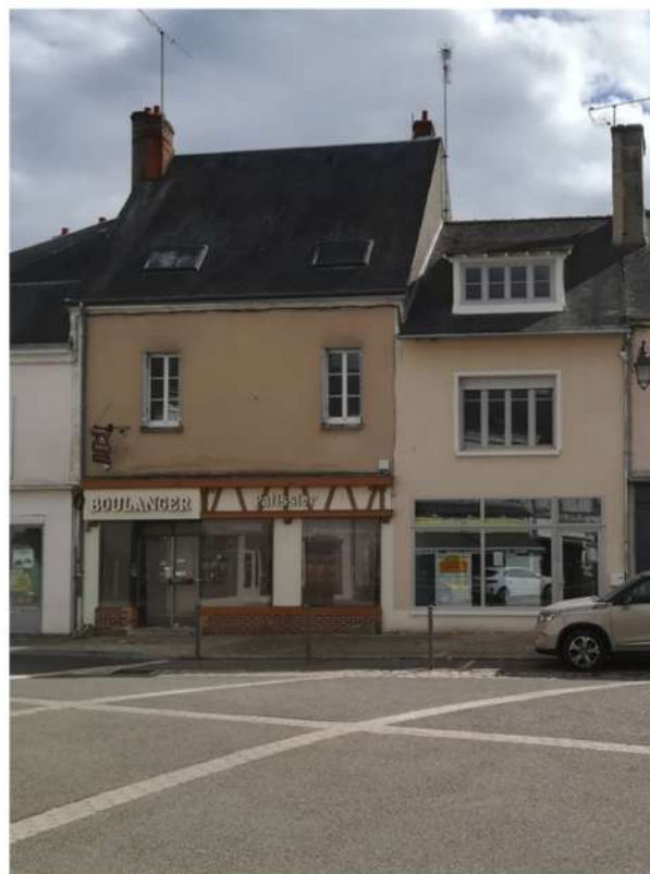
Réhabilitation d'un commerce de proximité - Beaune-la-Rolande (45)
